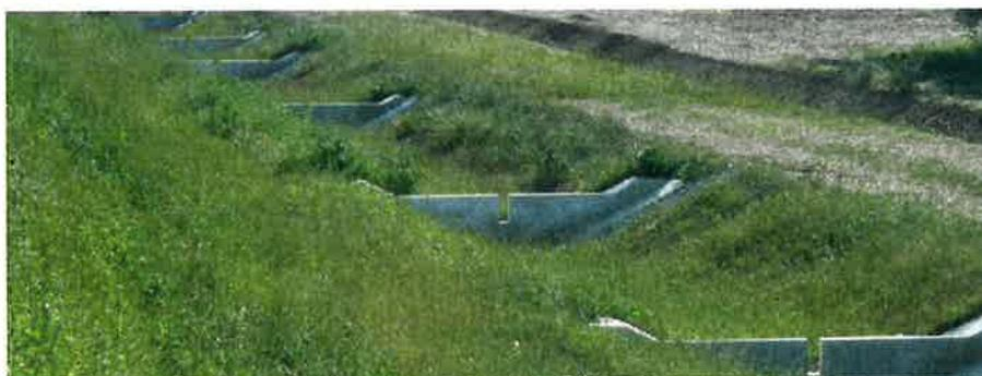
Principe de noue avec système de barrages.
